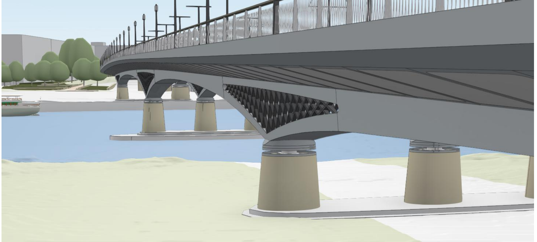
Ansicht Neustädter Ufer
